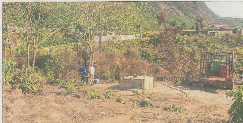
À quelques kilomètres de la capitale, le forage est déjà prêt et donne une rentabilité au-delà des espérances. La construction de l'usine va débuter en avril.
